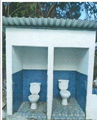
Foto 3: Mejoramiento y sustitución de servicios sanitarios y sus accesorios. Letrinas labables.
